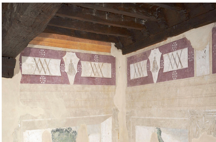
Fig. 3 Fascia decorata in finto porfido, contenente le imprese della Nappa e la Letteraria , Sala «Grande», Castello Visconteo di Voghera.
