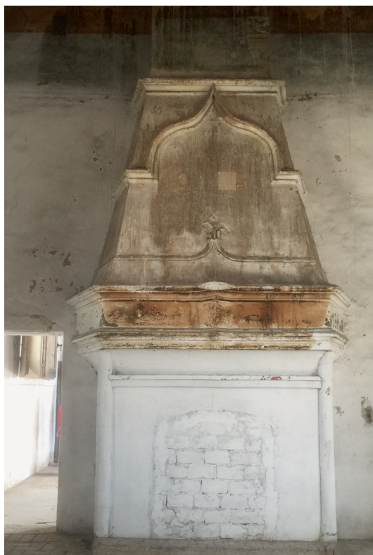
Fig. 17 Camino monumentale, Castello di Mirabello (PV).
